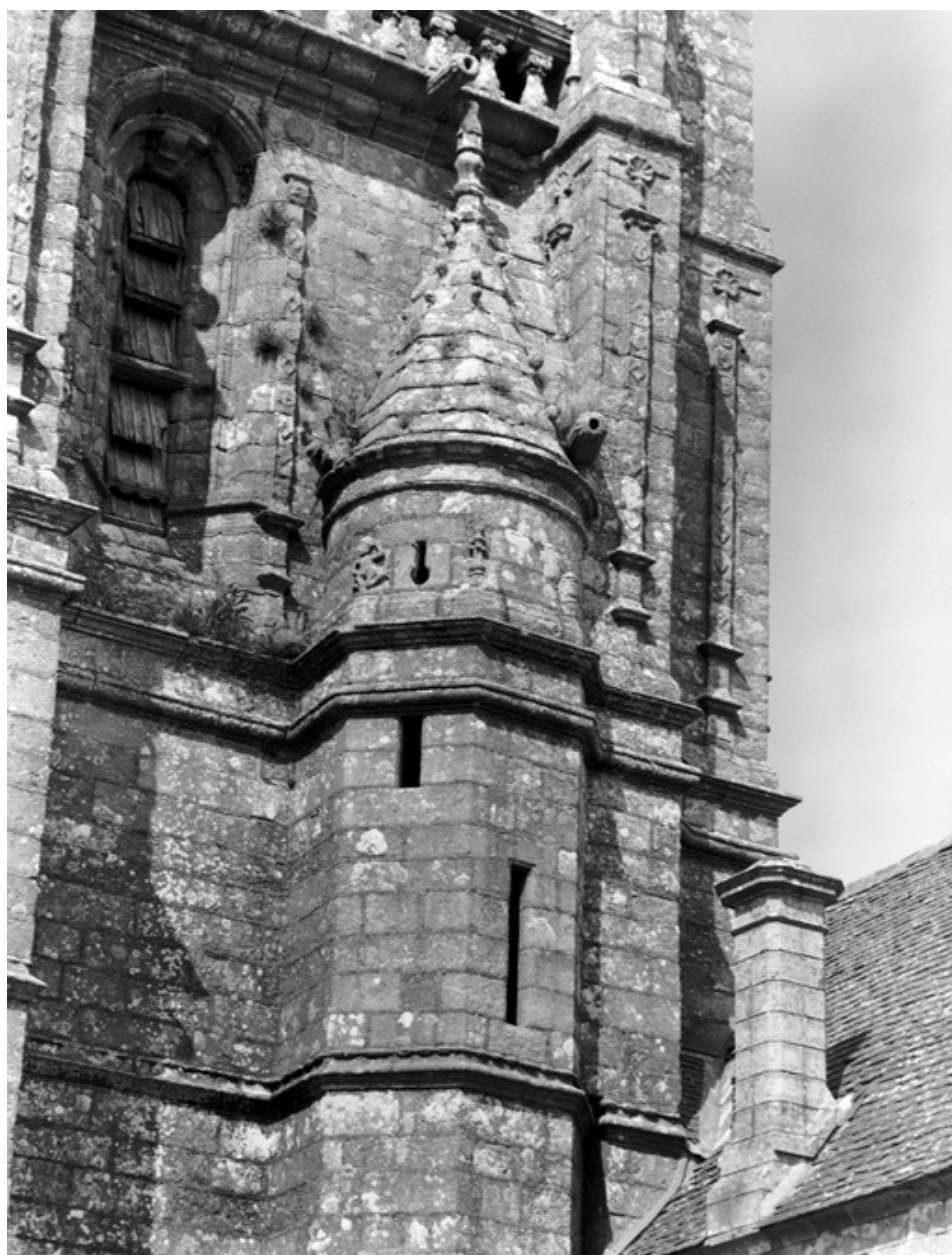
Tour ouest : tourelle d'escalier
