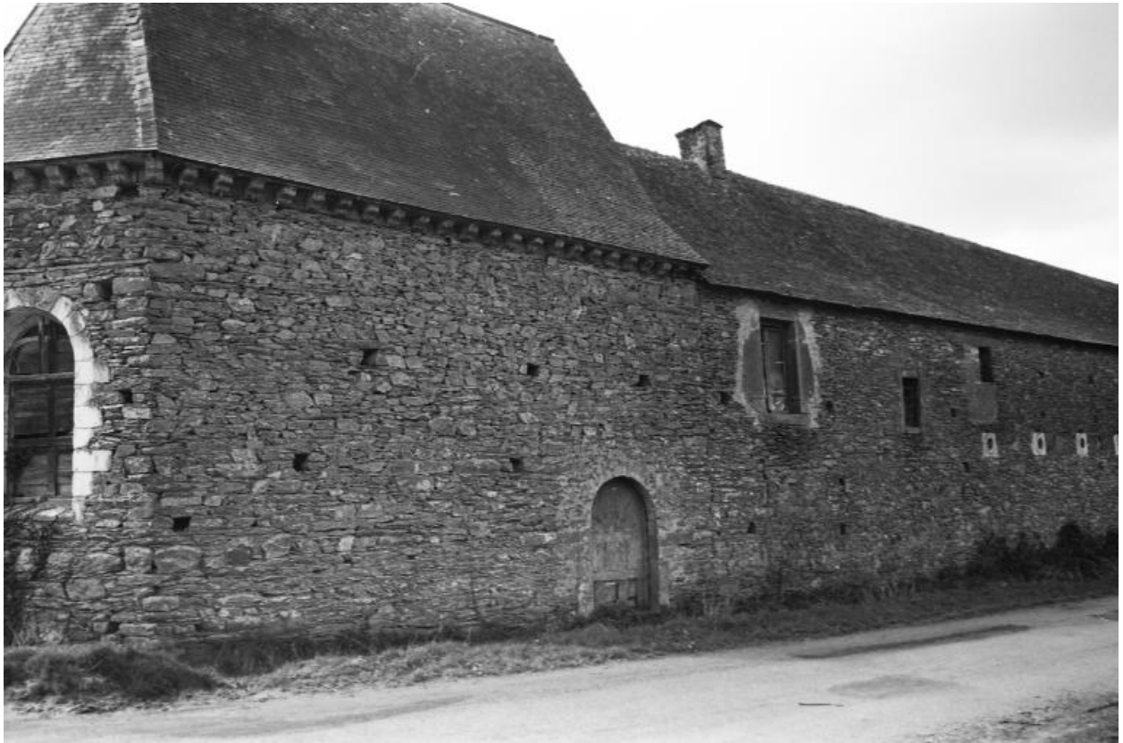
Ferme - Face ouest des bâtiments.
