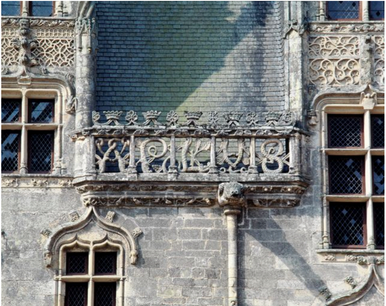
Logis, élévation sur cour : balustrade entre la 5e et 6e lucarnes
