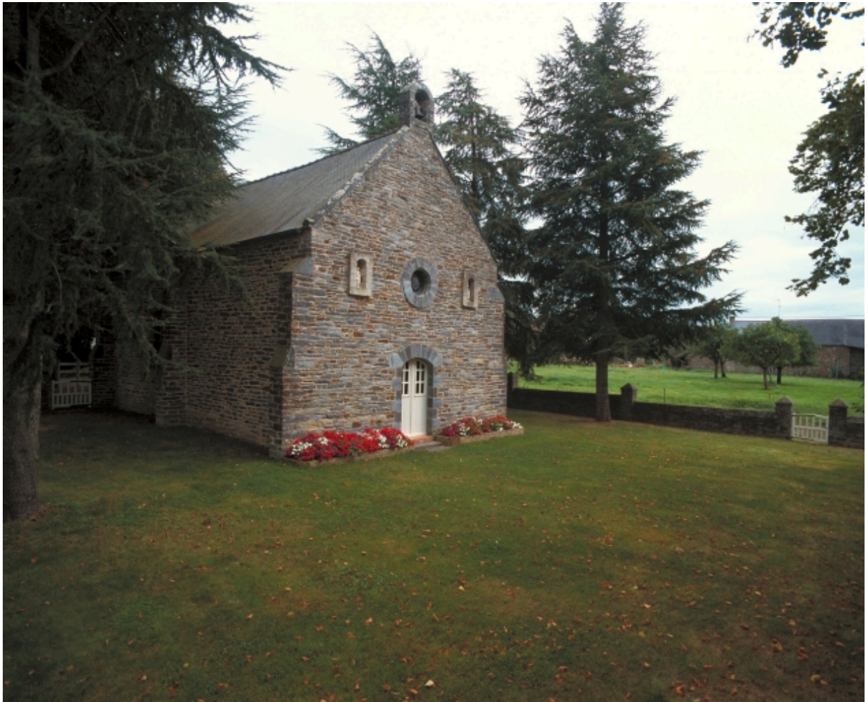
Élévation sud-ouest : vue générale
