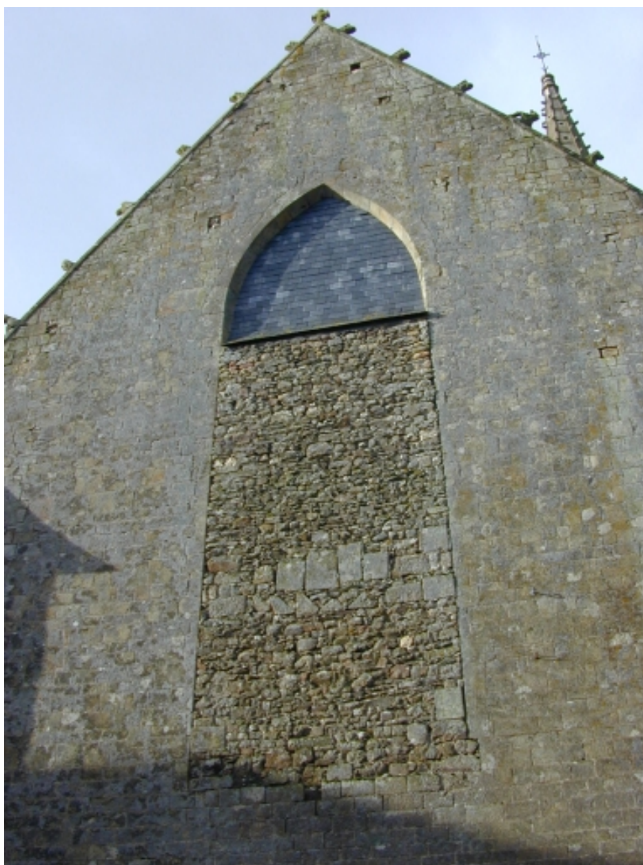
Façade est, le chevet avec baie murée
