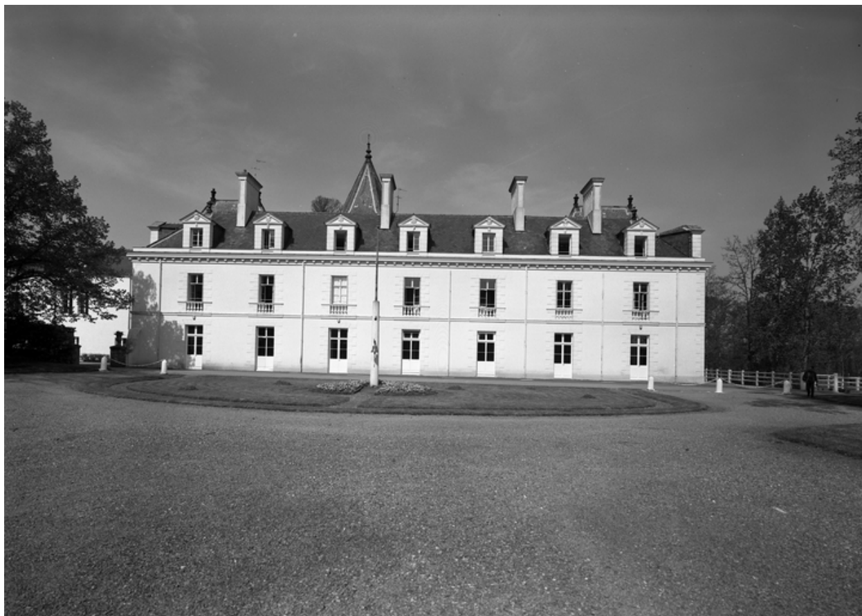
Vue générale de la façade principale est
