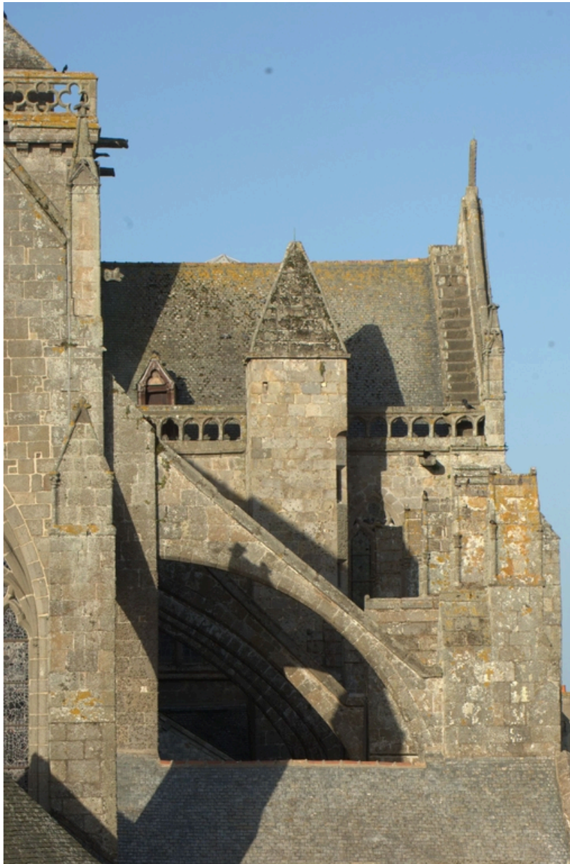
Arcs boutants du choeur côté nord, vue en enfilade
