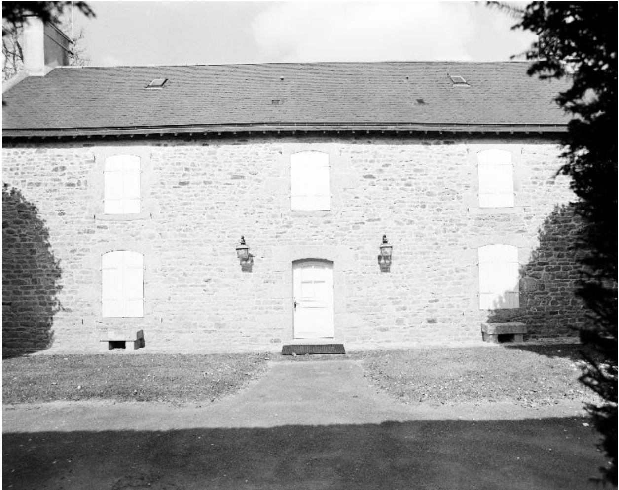
Dépendance, élévation sud.
