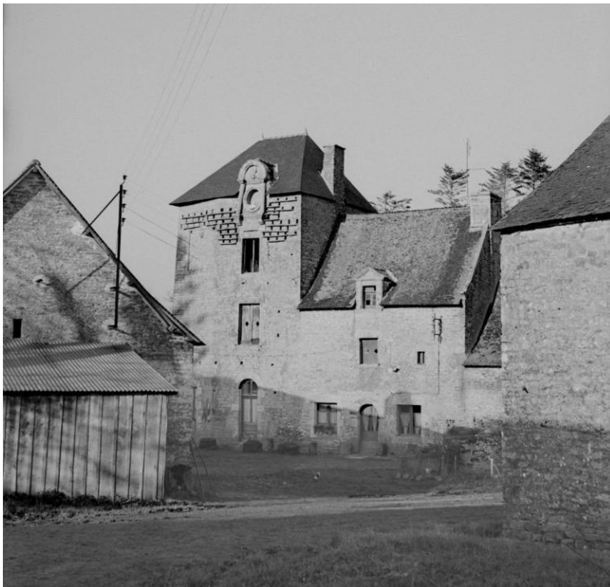
Vue générale prise du sud
