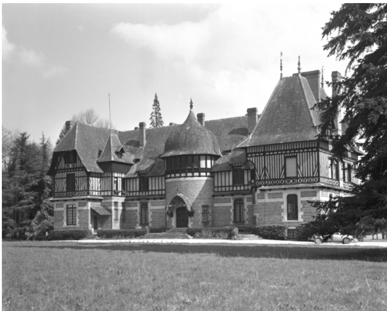
Vue générale sud-ouest en 1982
