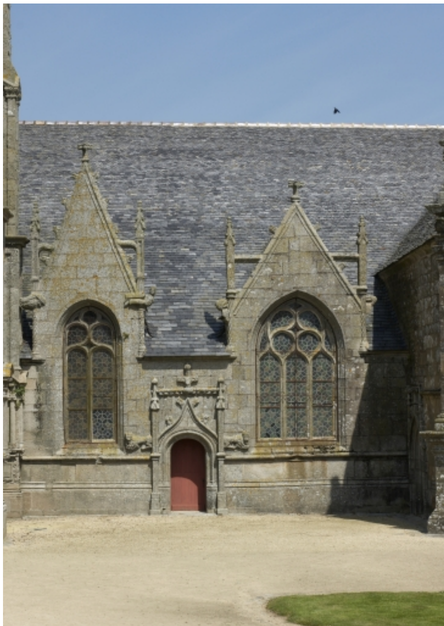
Elévation sud, détail des ouvertures entre la tour-porche et le bras sud
