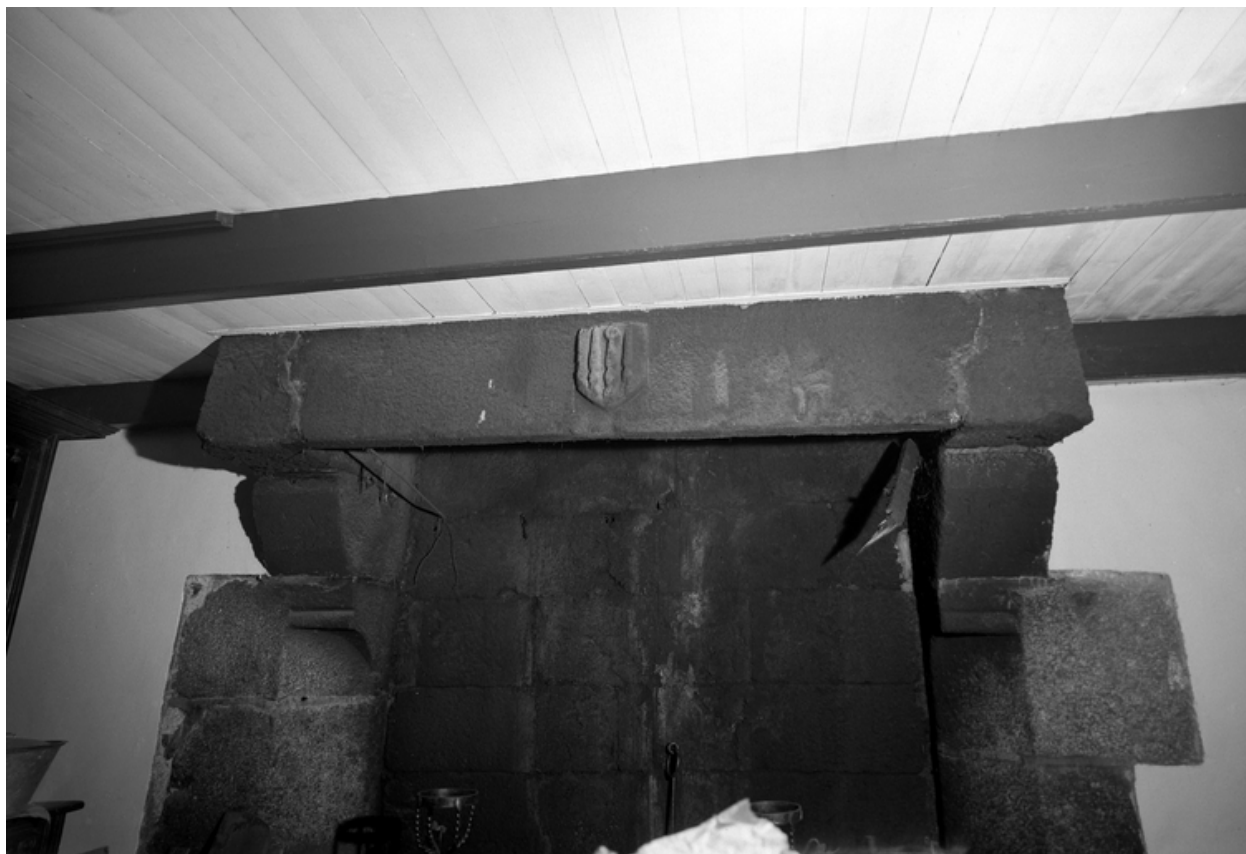
Rez-de-chaussée, mur est : détail de la cheminée
