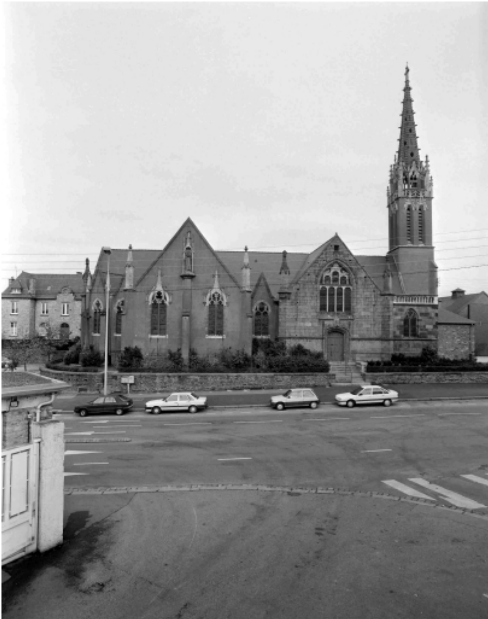
Elévation sud, en 1994
