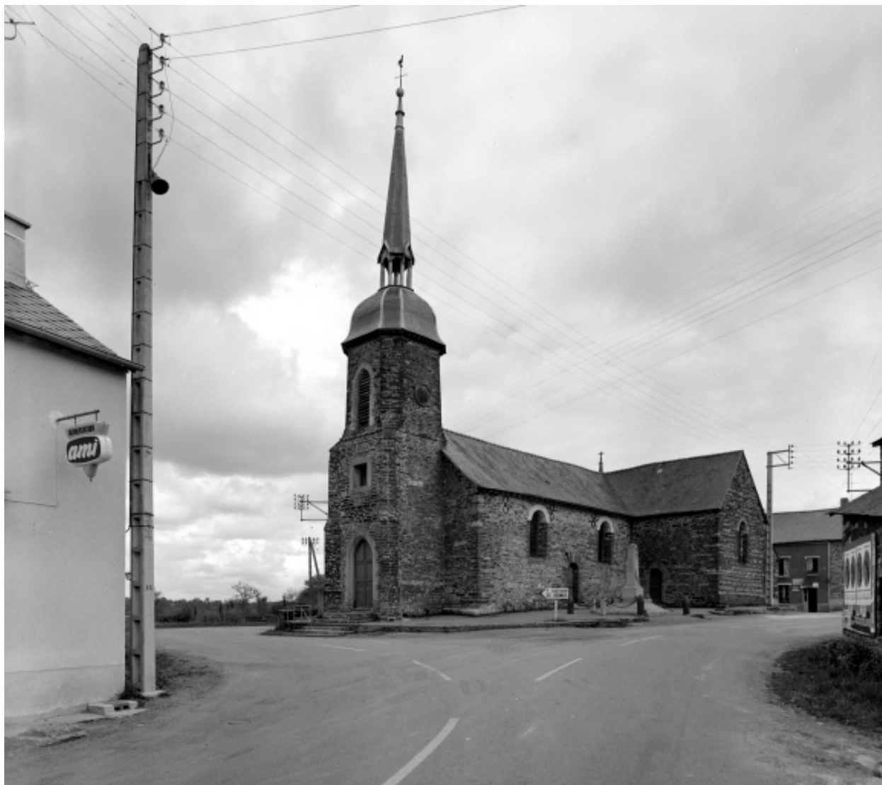
Elévation sud-ouest : vue générale
