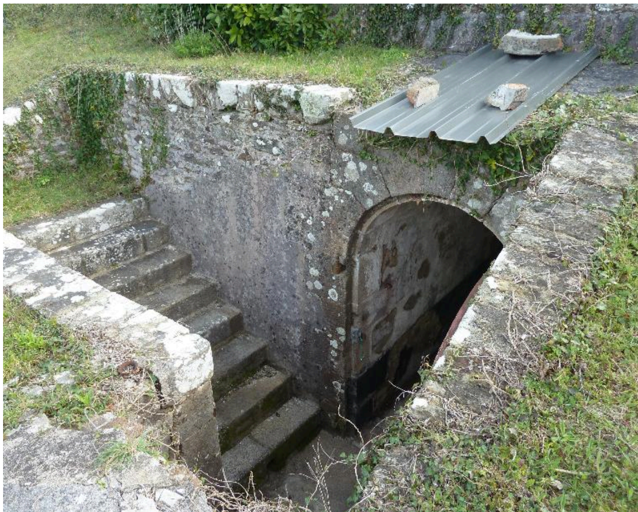
Le Palais, enceinte urbaine, réduit A, terrasse, débouché de l'escalier.
