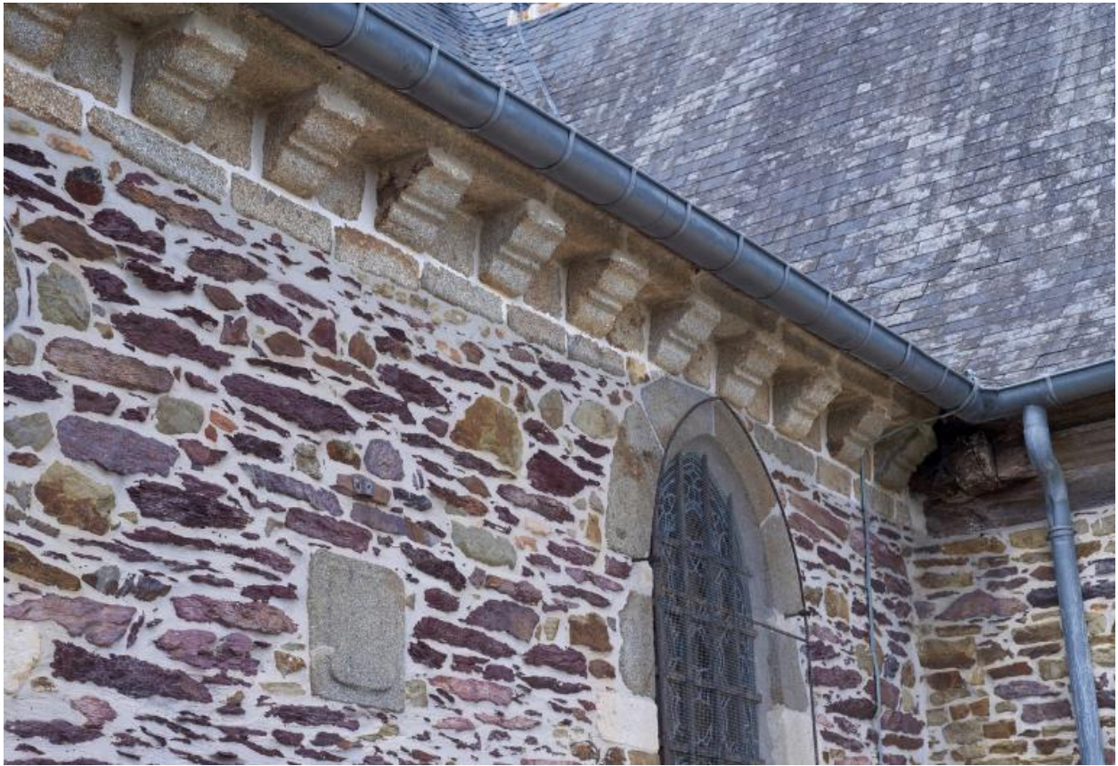
Collatéral sud : Détail corbelets sculptés en pierre
