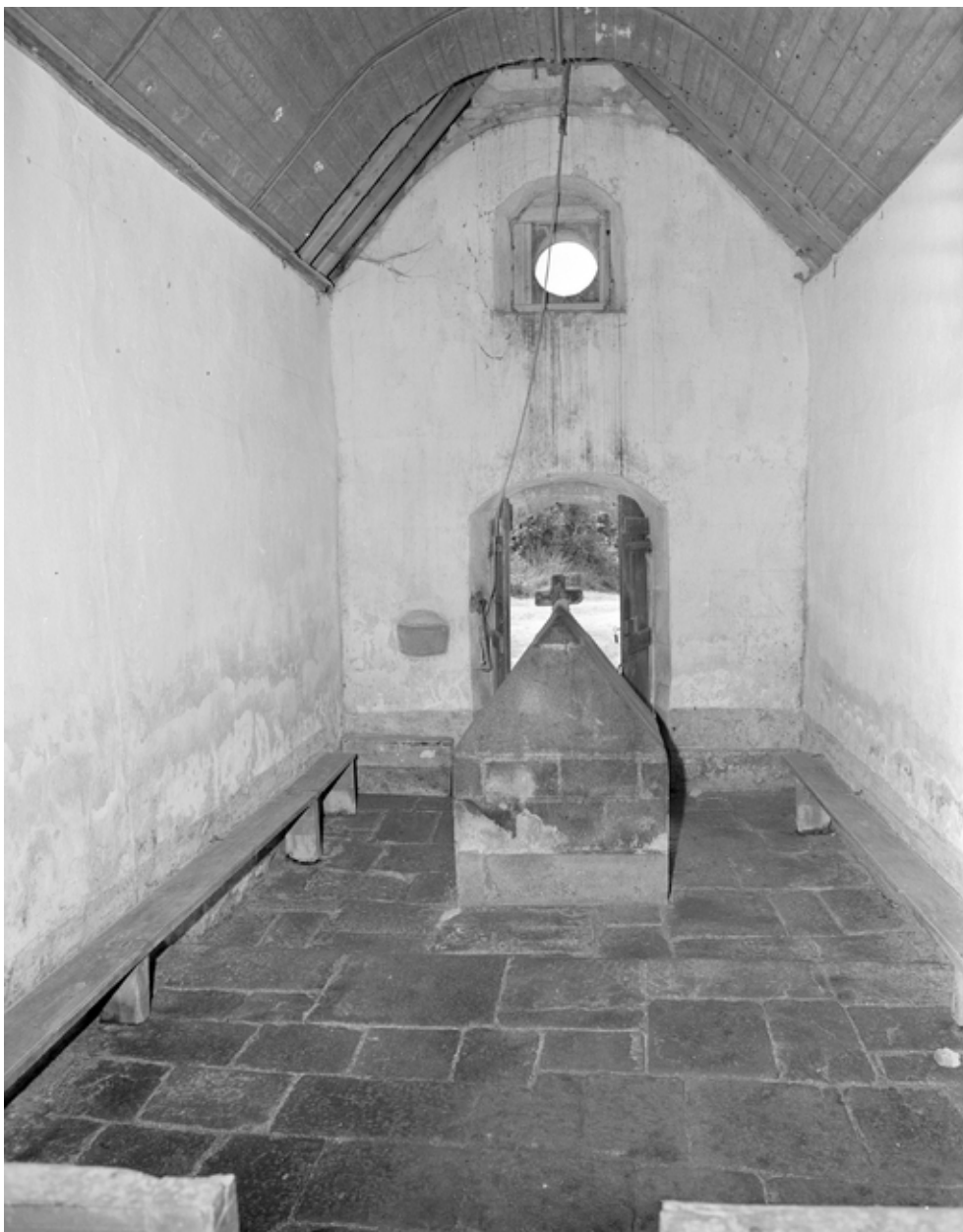
Primelin, chapelle Saint-Chrysanthe : vue intérieure est/ouest, état en 1978
