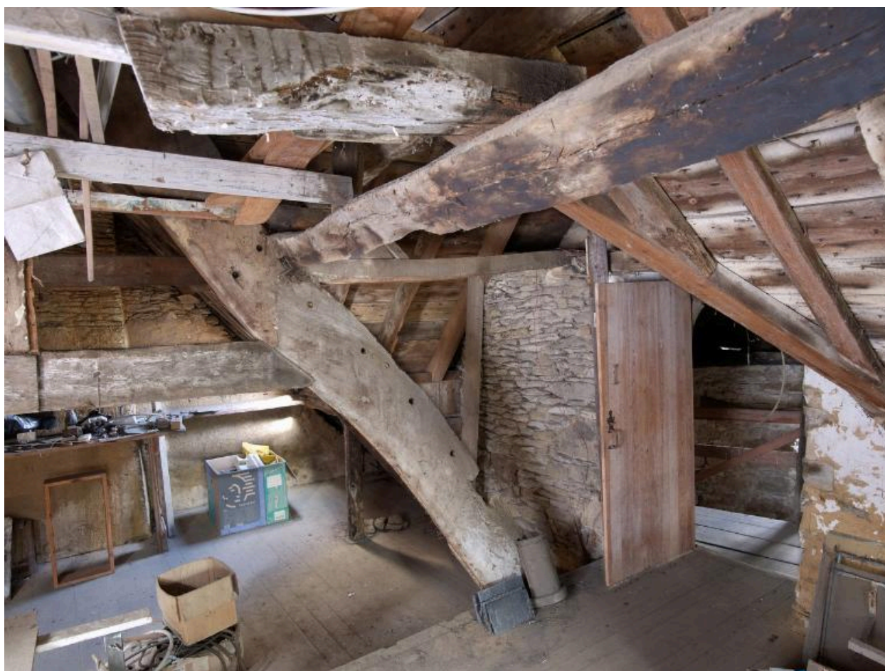
Combles. Vue partielle de la charpente
