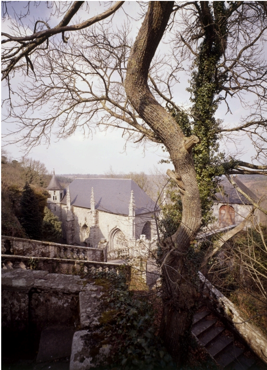
Vue de situation sud-est.
