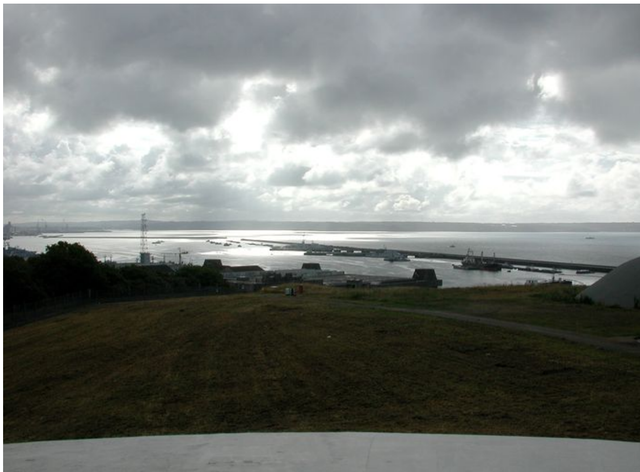
Vue générale du parc à carburant de Maison Blanche : il domine la rade abri
