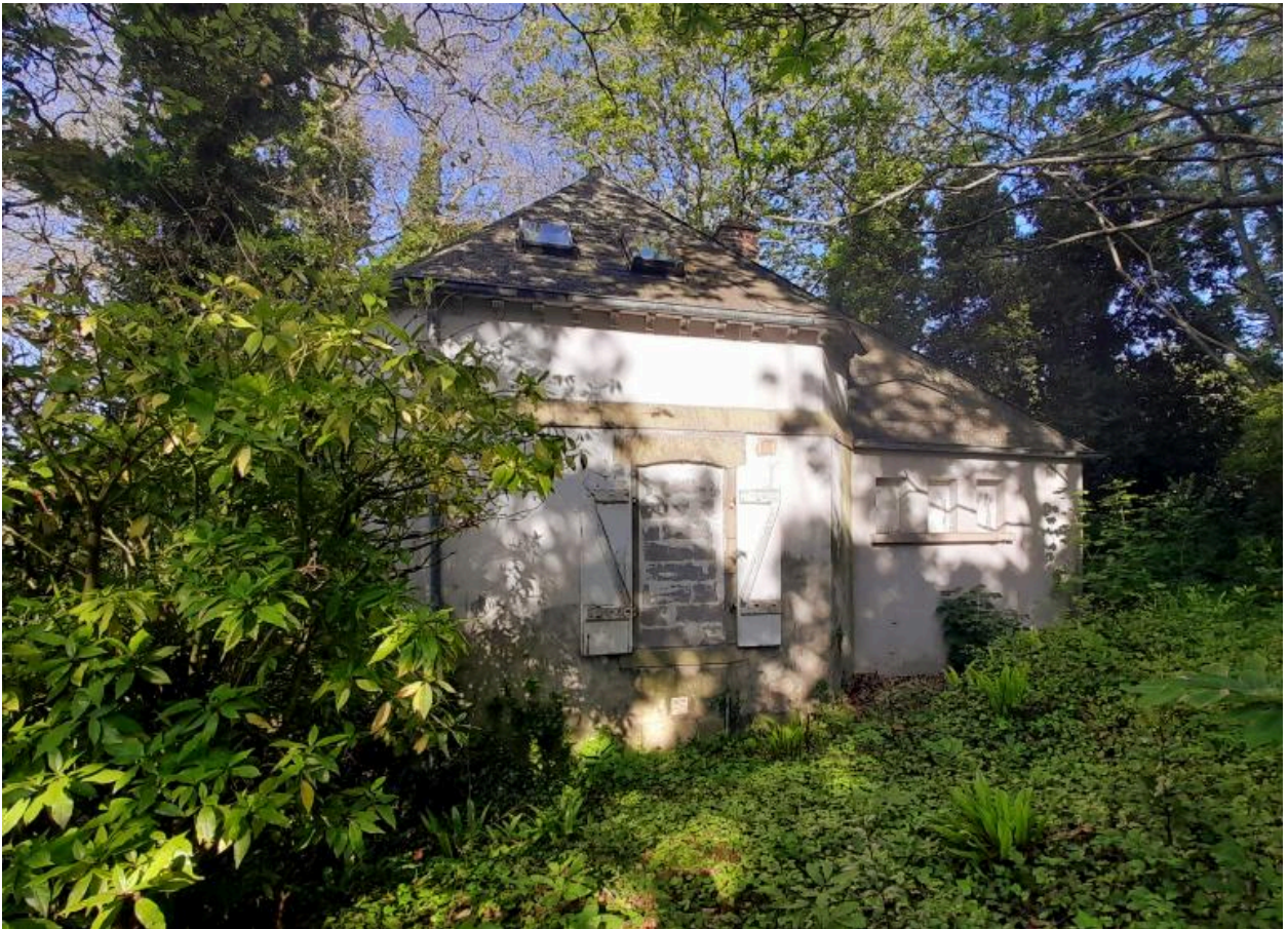
Maison de garde à l'entrée sud du domaine, élévation est. (2023)
