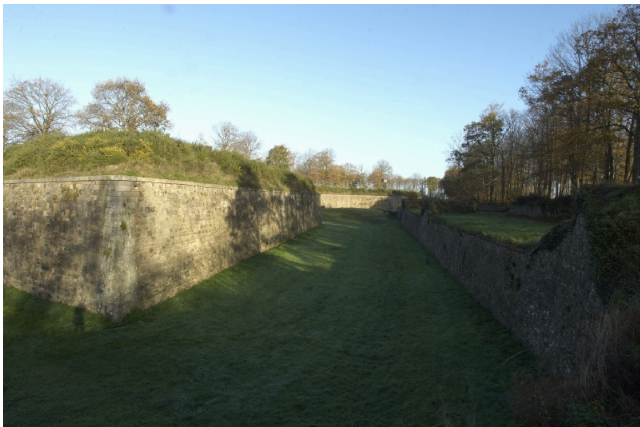
Vue générale du front est
