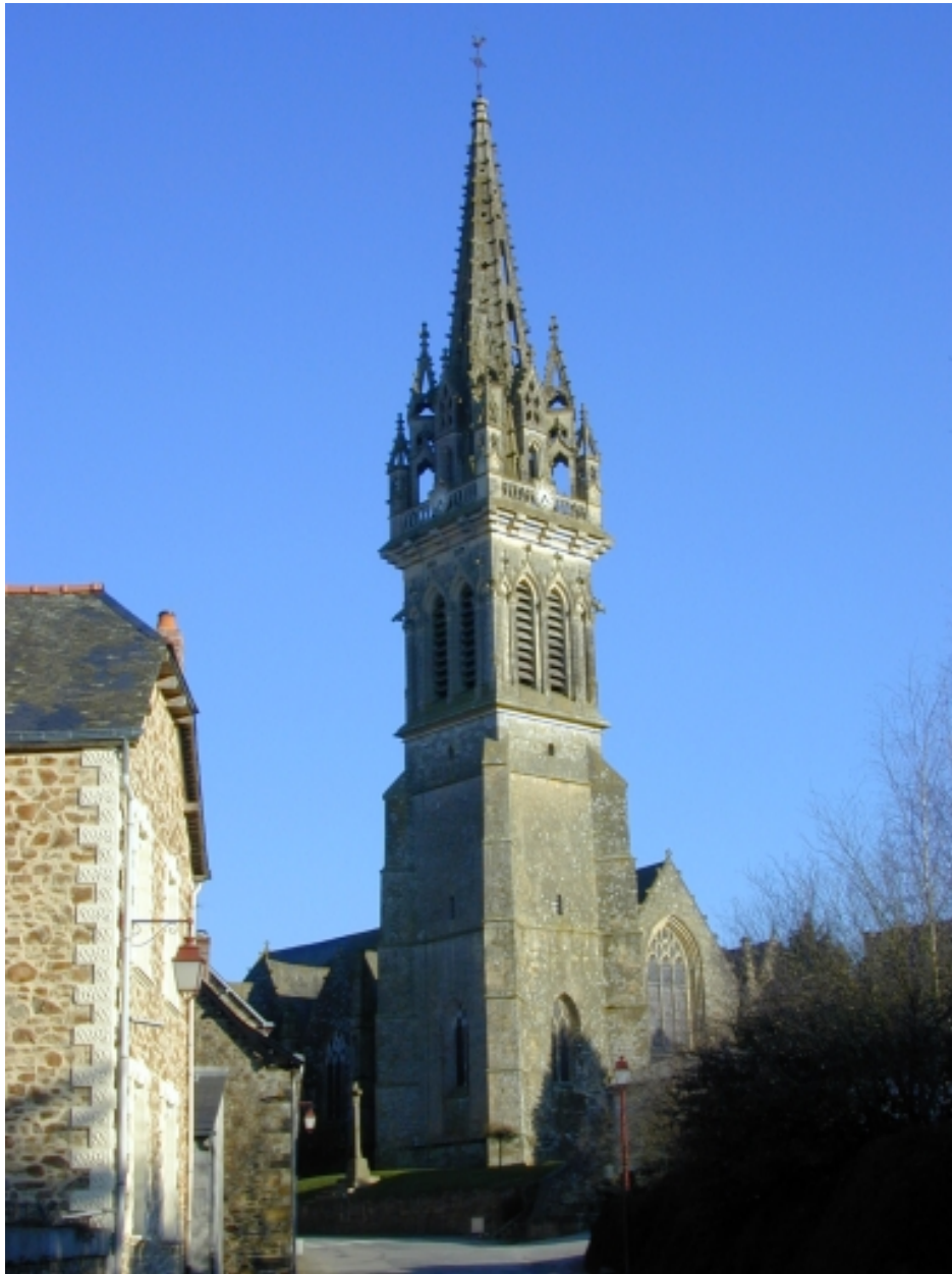
Le clocher vue depuis la route de Bais : vue de situation nord-ouest
