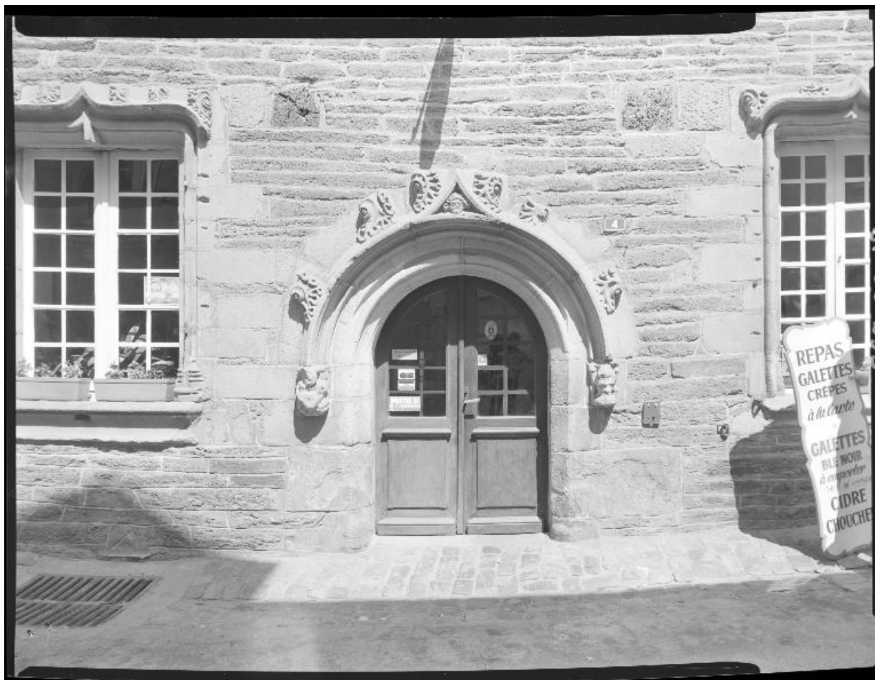
Maison : la porte (état en 1984)
