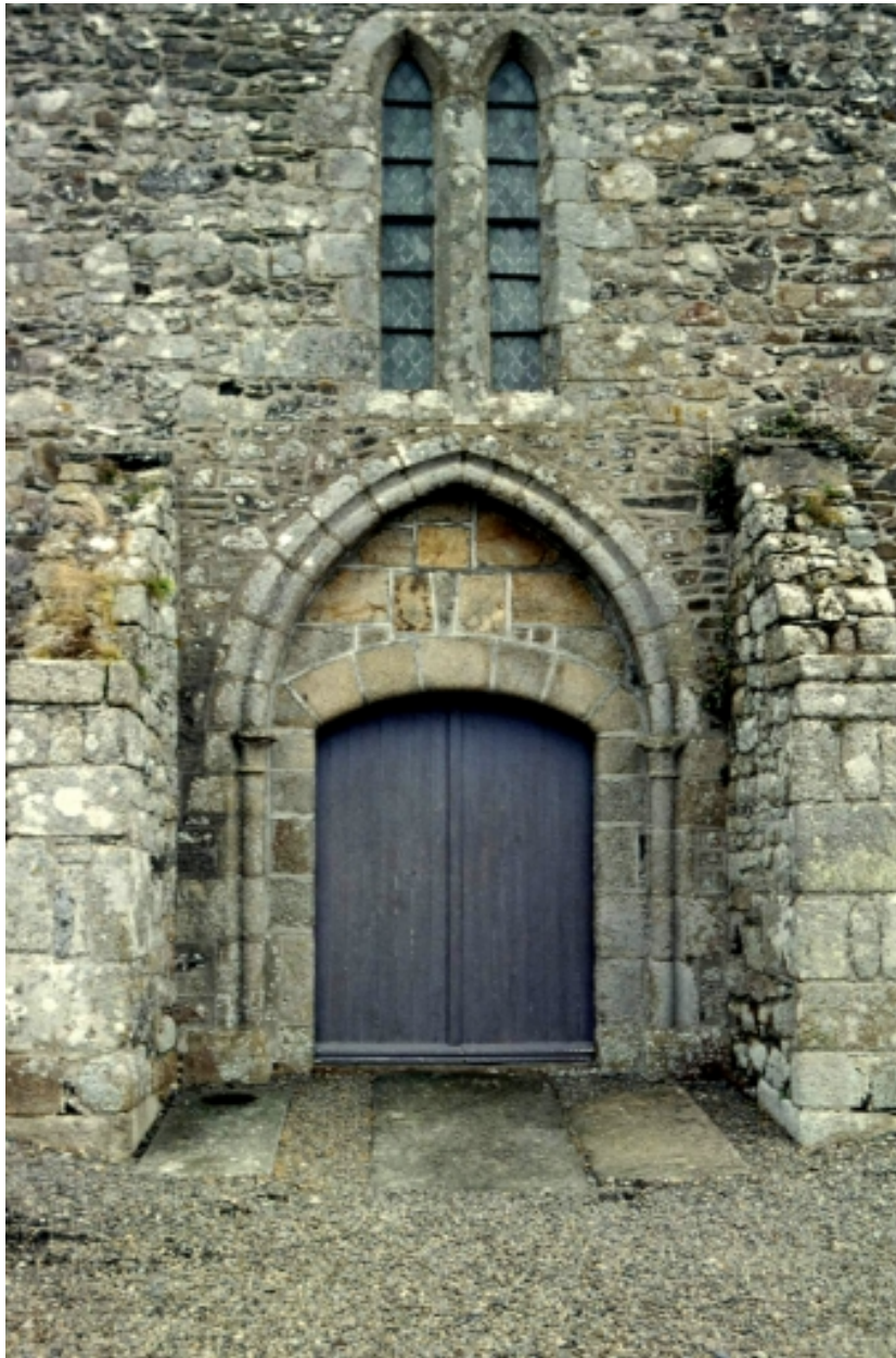
Elévation sud : détail fenêtre.
