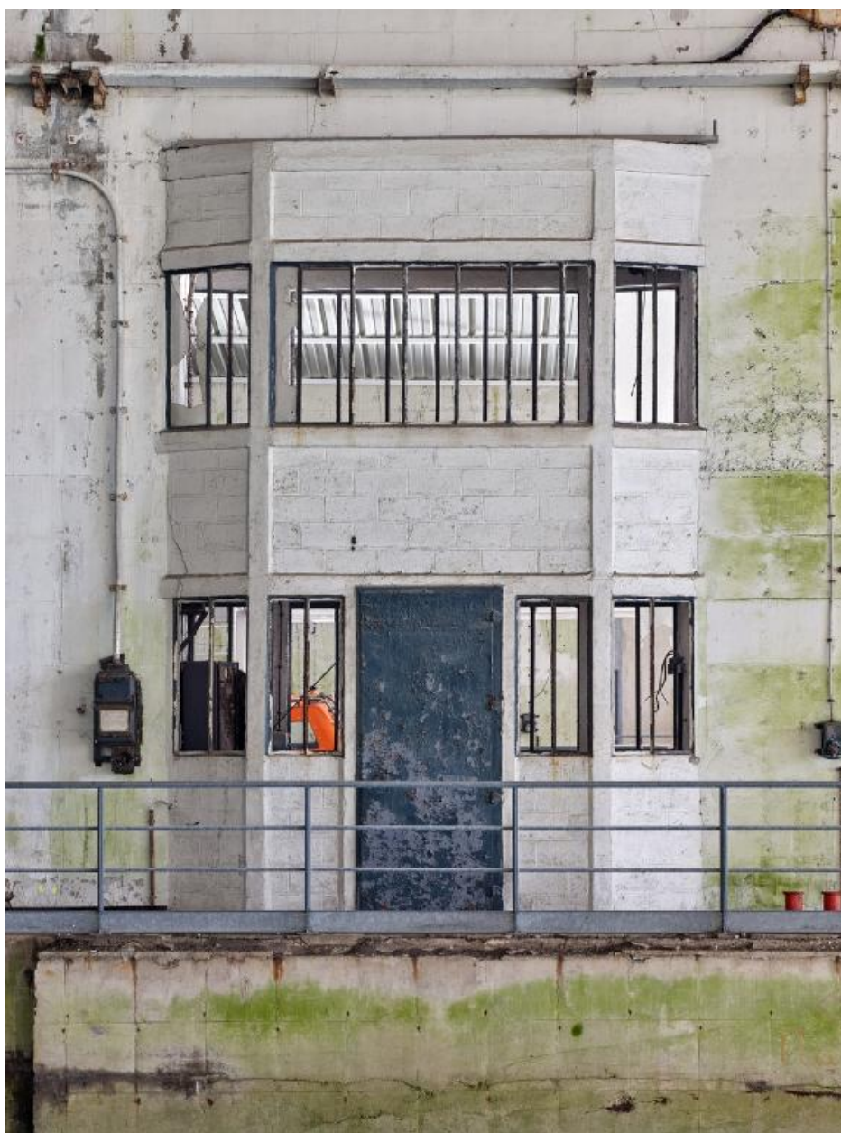
Vue de la salle des pompes aménagée dans l'épaisseur du mur de refend entre les alvéoles D et E. Au premier plan, le quai n° 19
