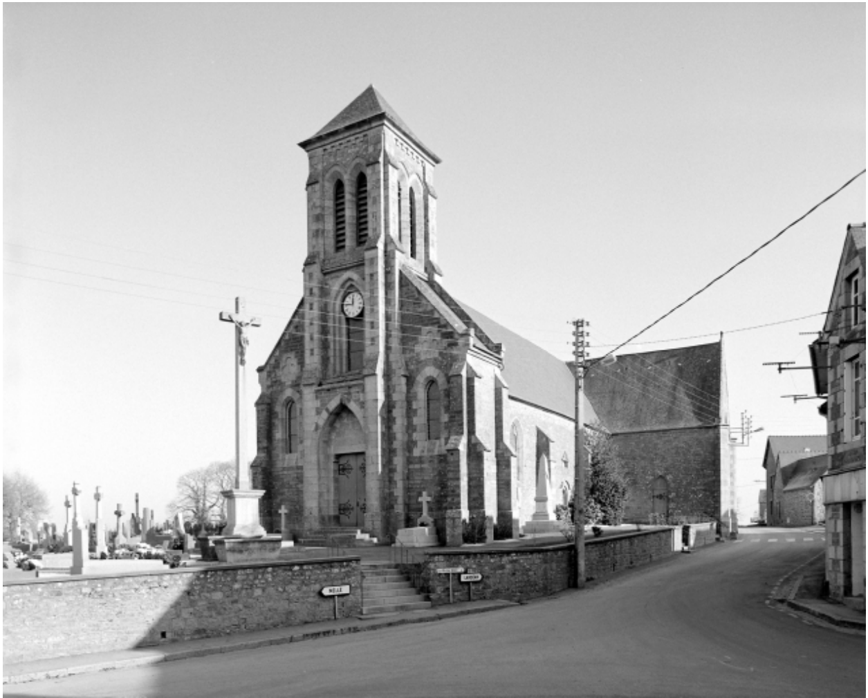
Elévation Sud-Ouest : vue générale
