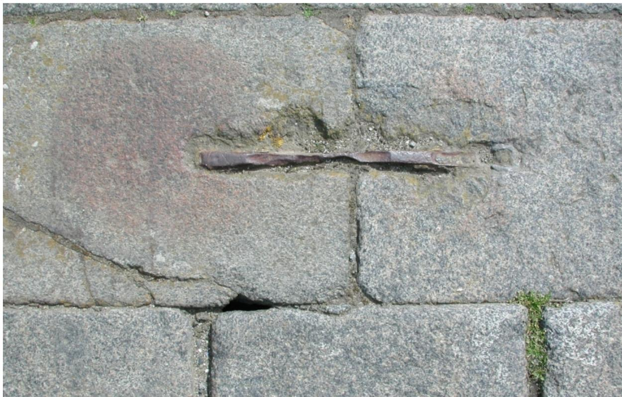
Détail d'assemblage des pierres de parement de la jetée
