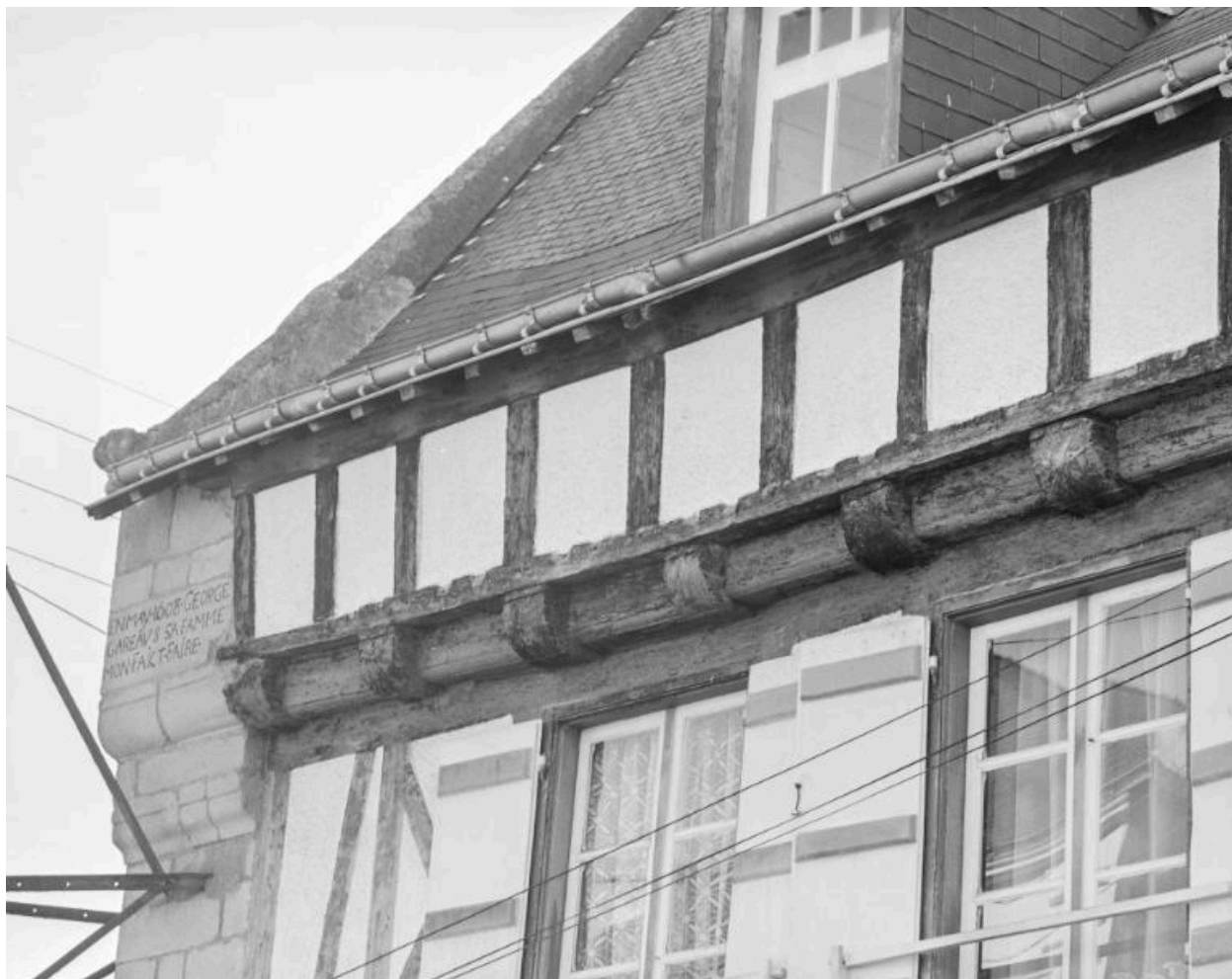
Etage en surcroît et inscription (1608) sur le mur pignon.
