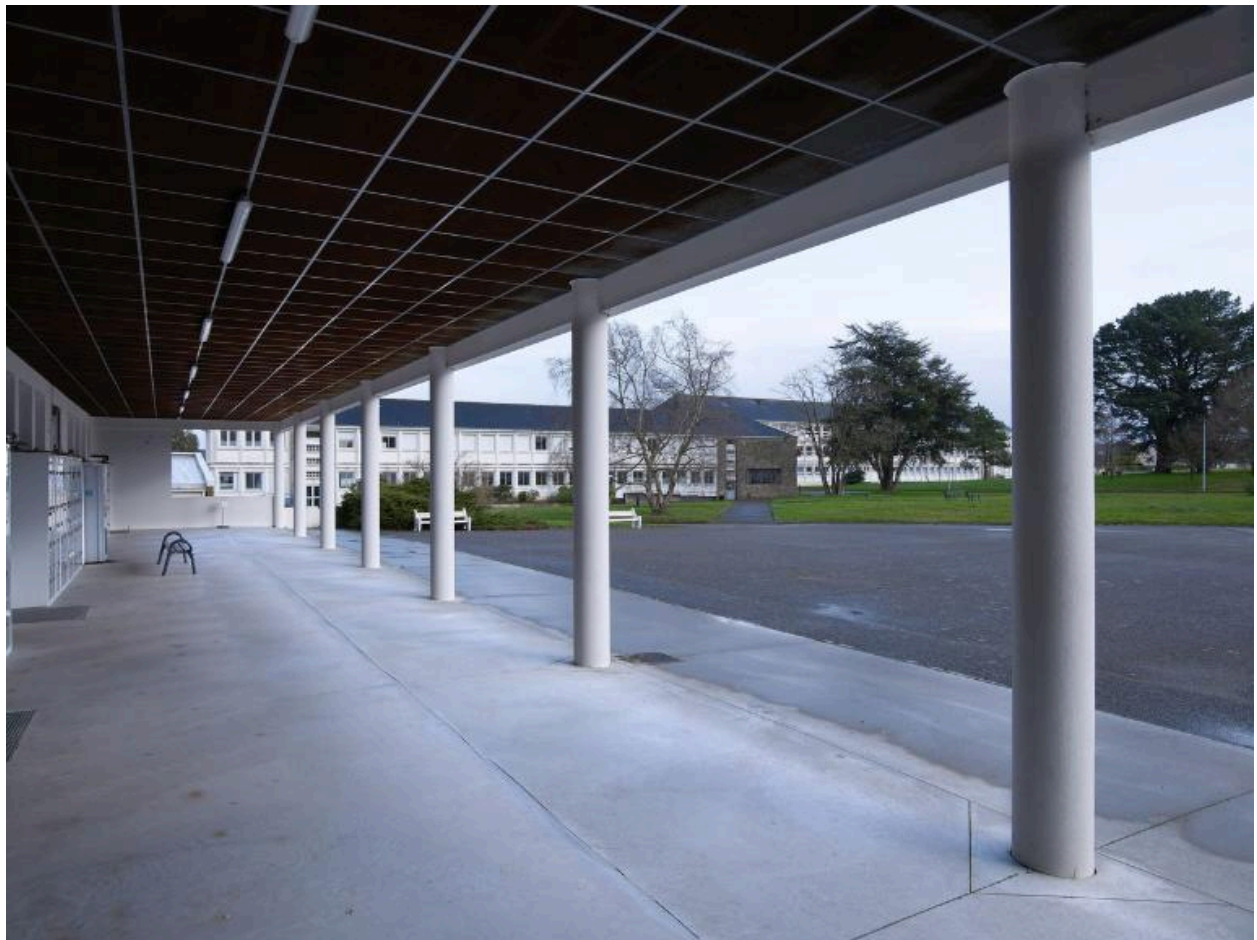
Vue prise sous le préau des ateliers. Yves Guillou, architecte, 1962.
