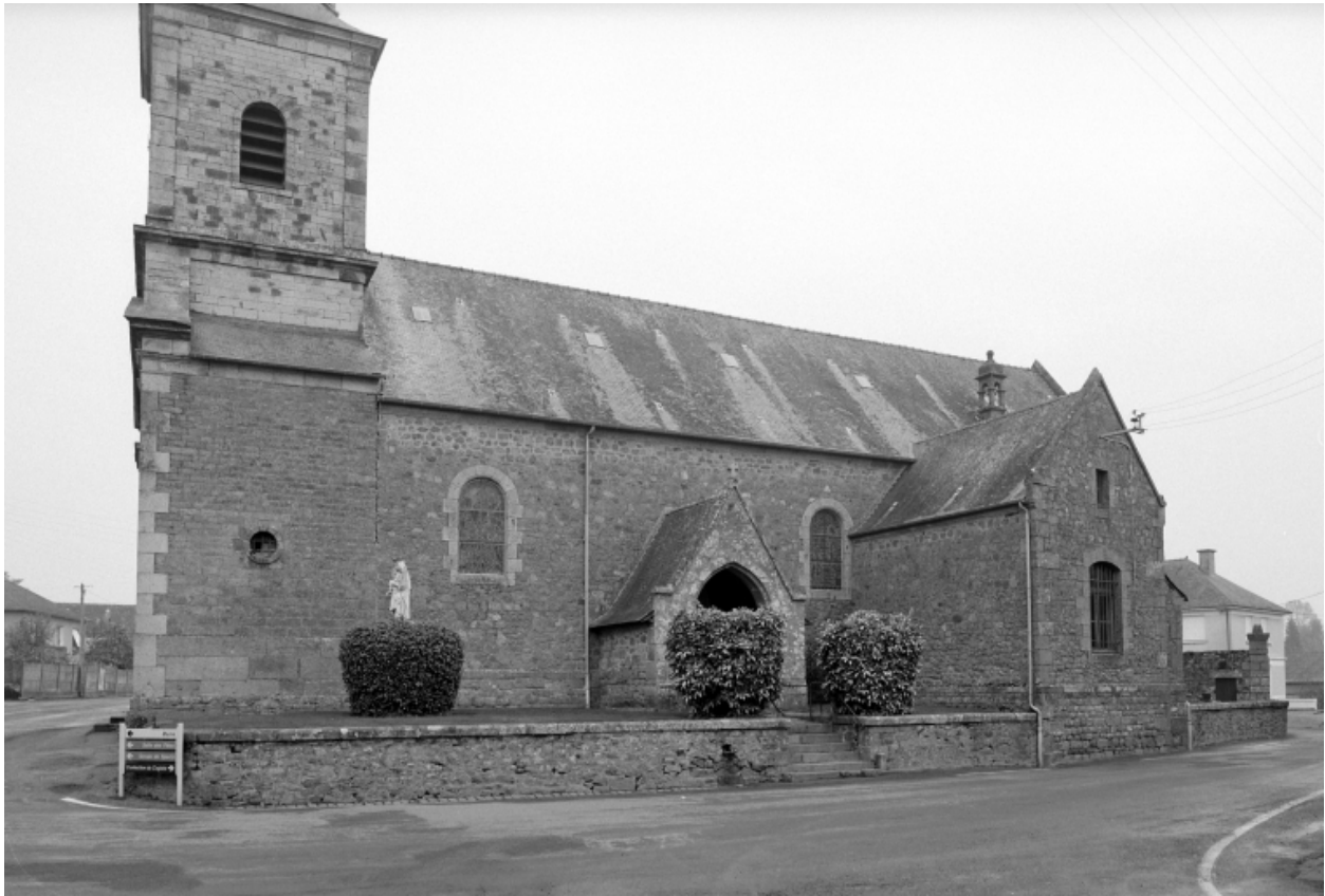
Elévation Sud : vue générale
