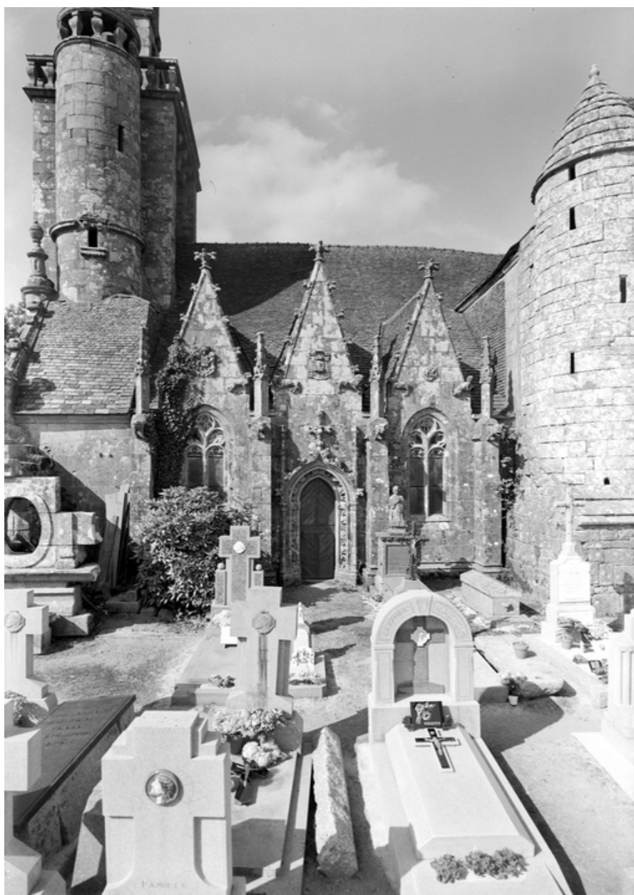
Façade sud : vue générale de la partie ouest
