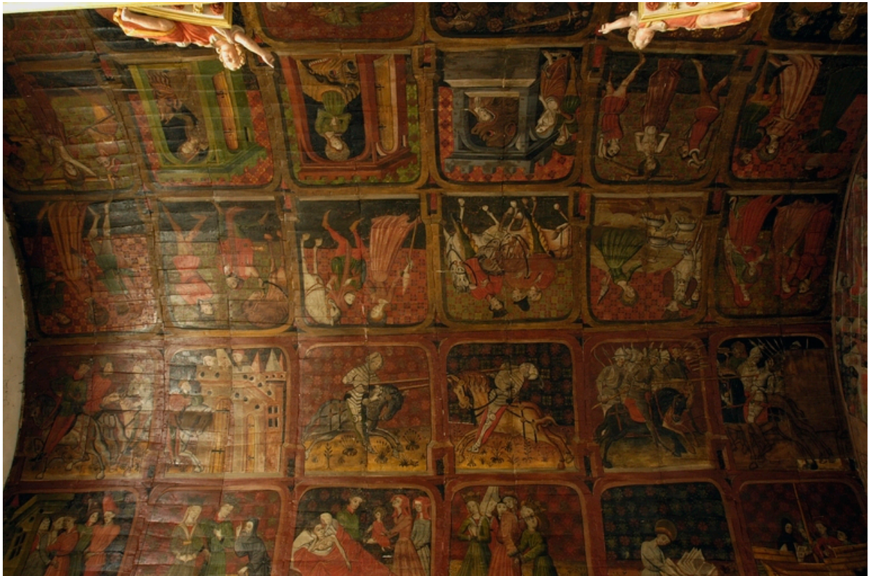
Vue frontale du lambris peint de la fausse voûte
