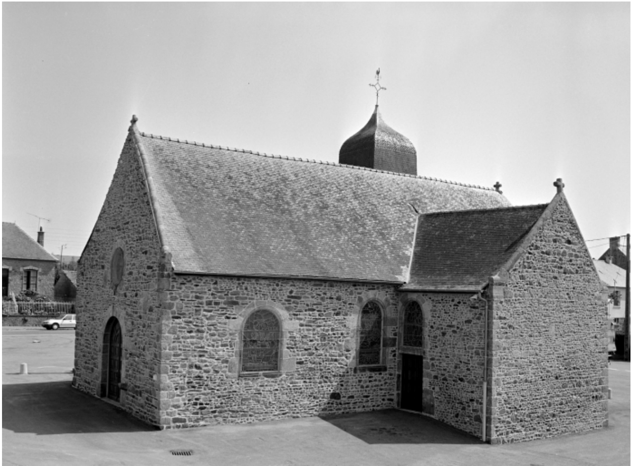
Elévation Sud-Ouest : vue générale
