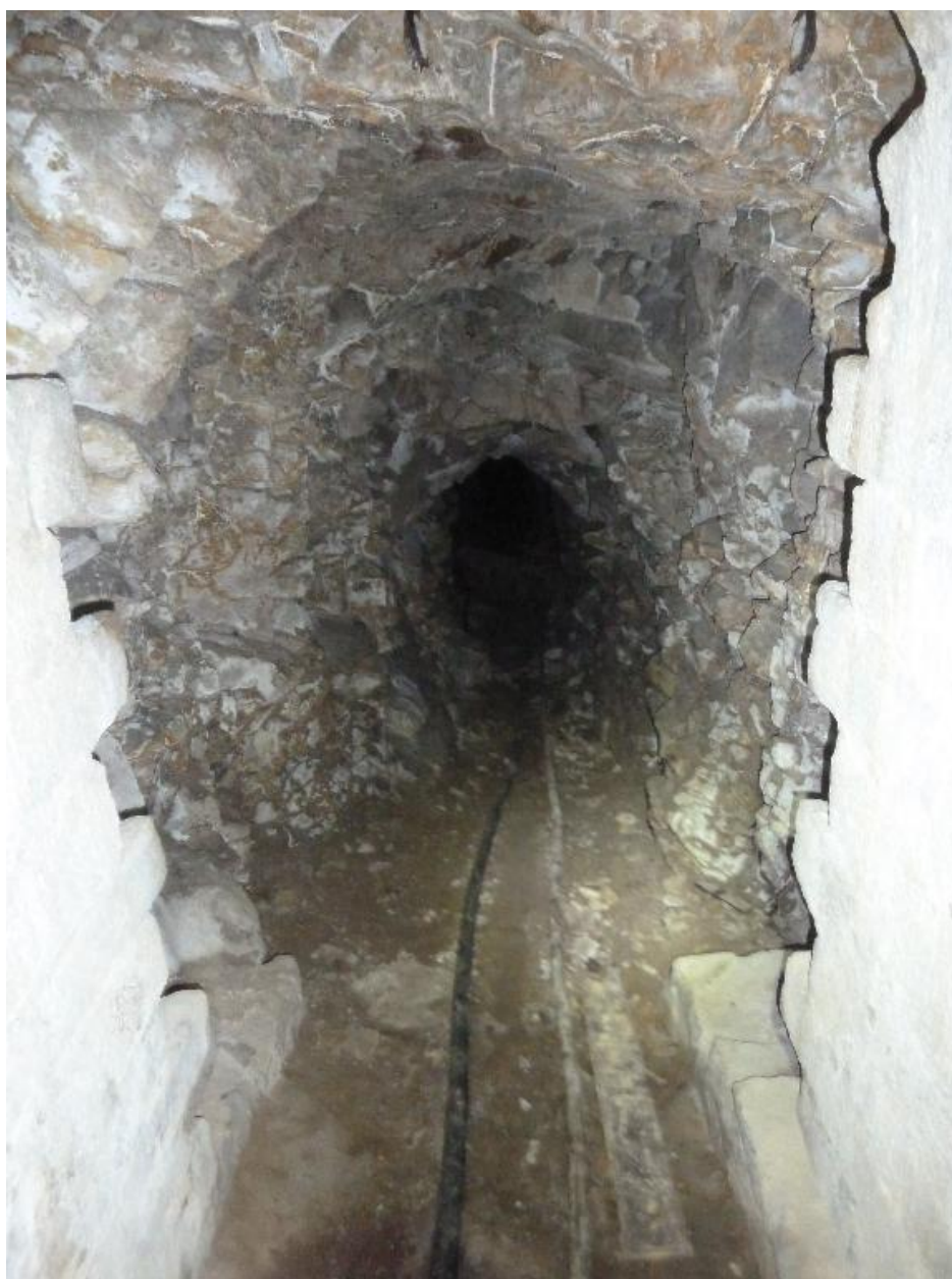
Saint-Pierre-Quiberon, fort de Penthievre, enceinte, galerie de mine en capitale.
