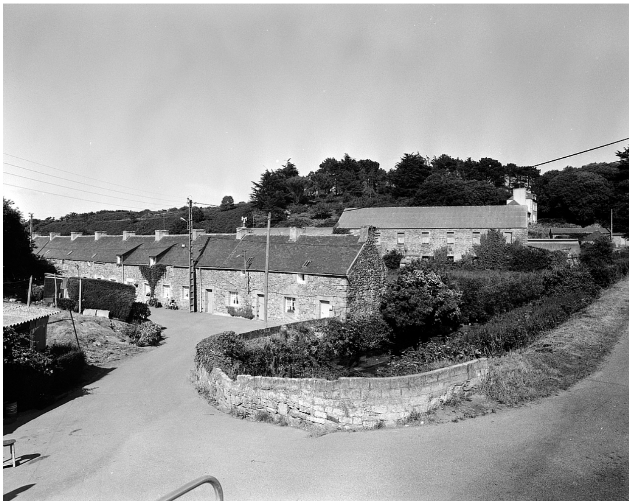
Maison d'ouvriers, vue de situation prise du sud-ouest
