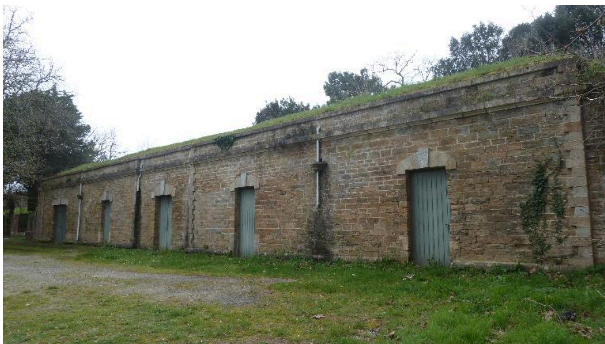
Le Palais, enceinte urbaine, réduit C, façade de gorge.
