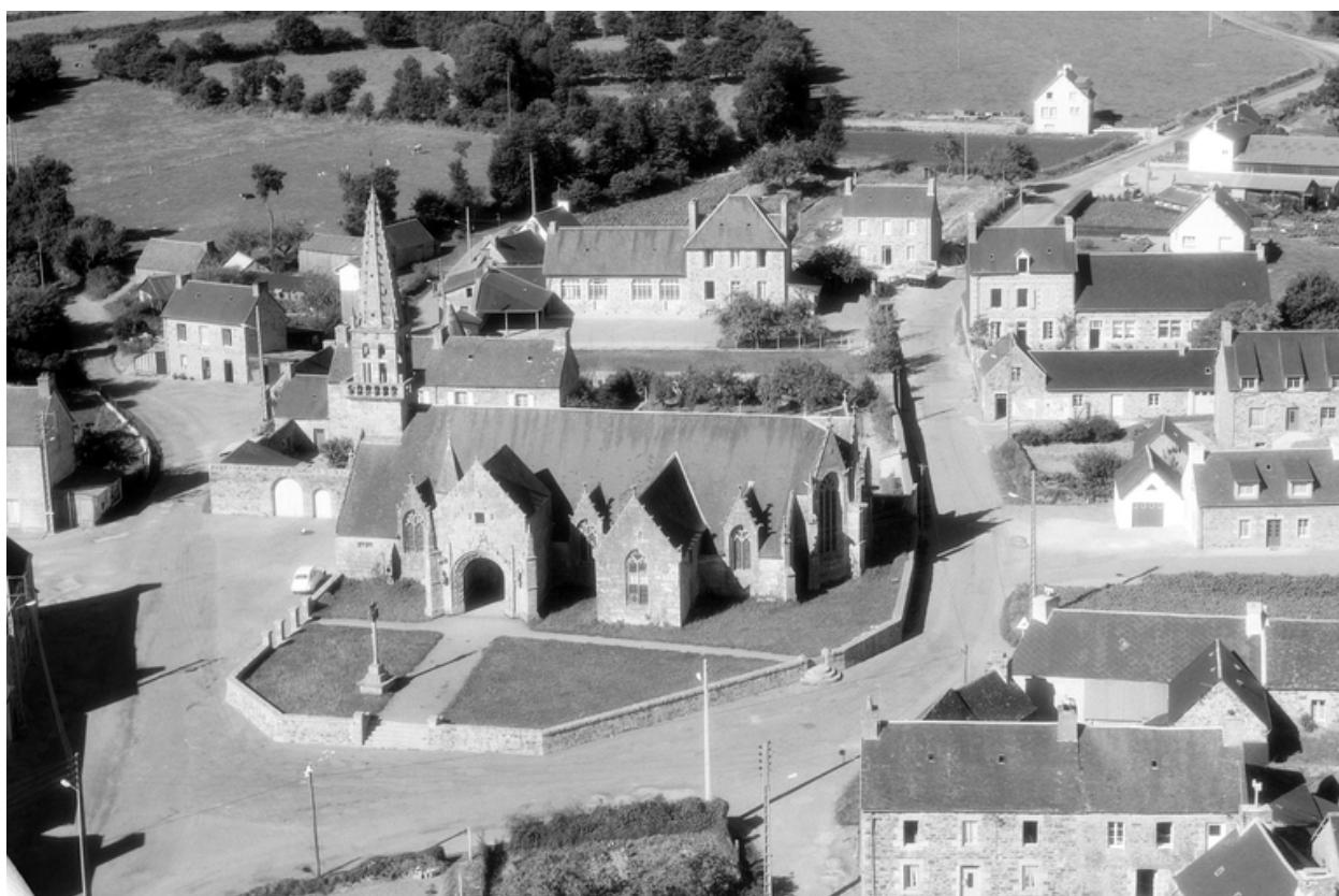
Vue de situation prise du sud
