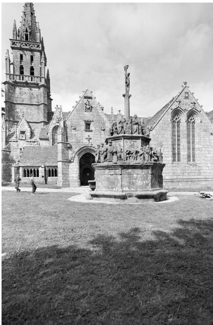
Face sud : vue générale
