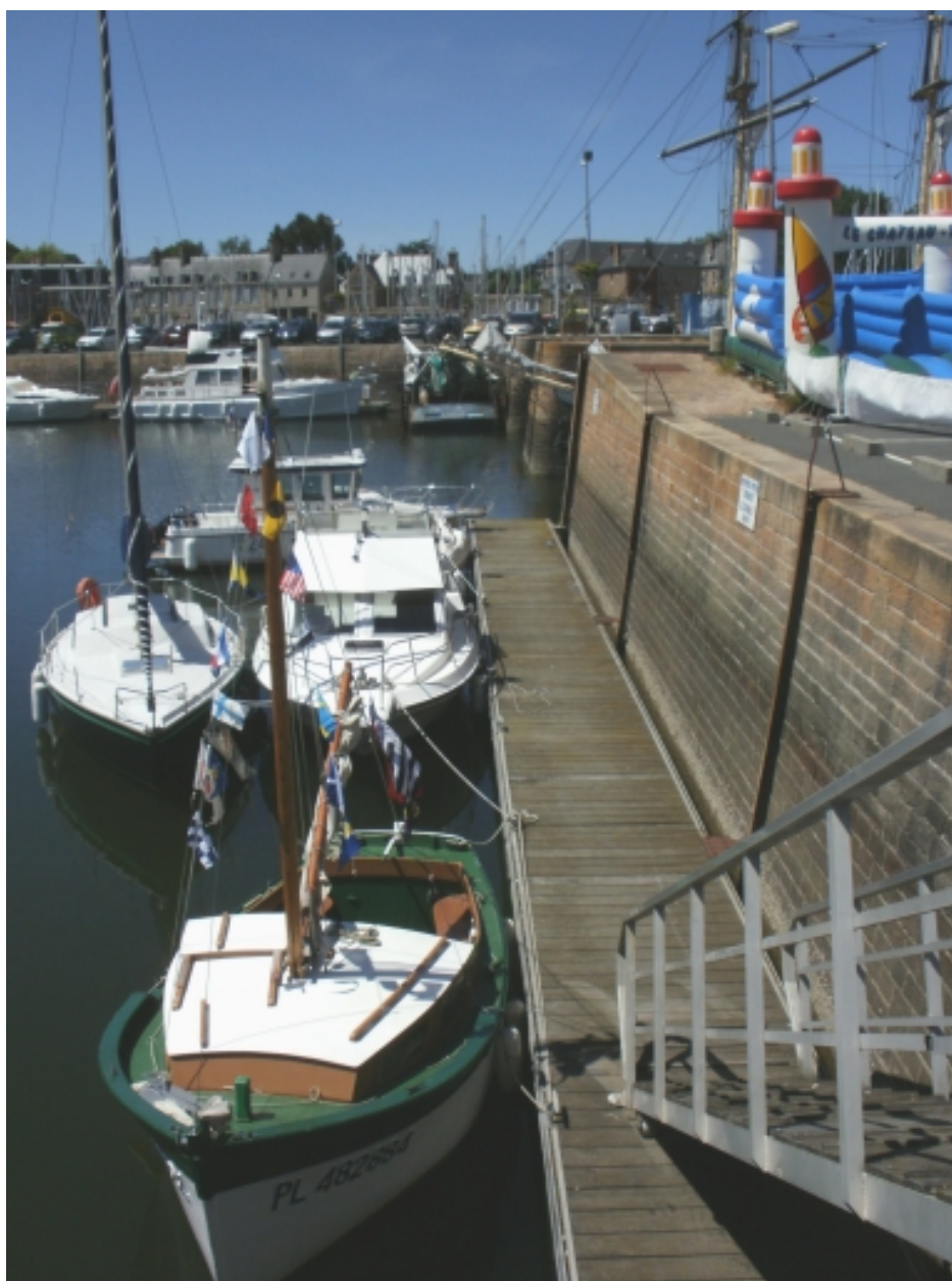
Vue du ponton et du quai réservé aux bateaux de pêche
