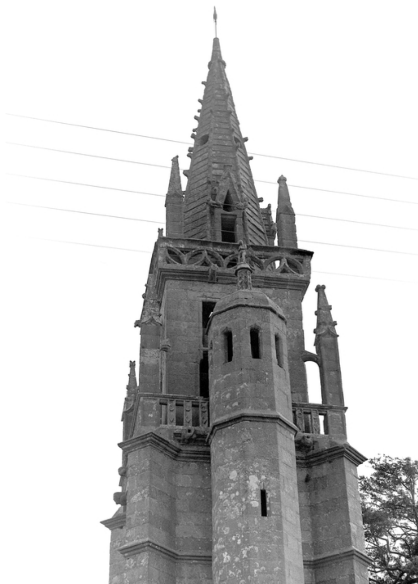
Clocher, face nord : détail du 3ème niveau et de la flèche
