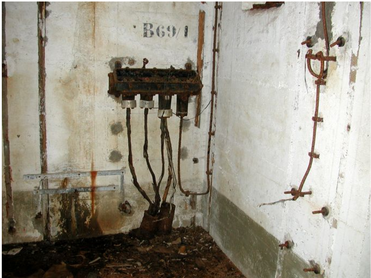
Vue de la chambre de troupe de droite : boîtier de connexion téléphonique surmonté du numéro "B 69/1" et câblage (état en 2003)
