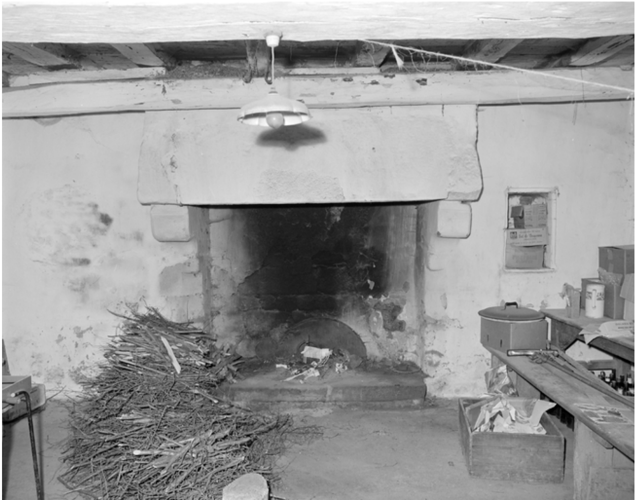
Cheminée, rez-de-chaussée, mur ouest
