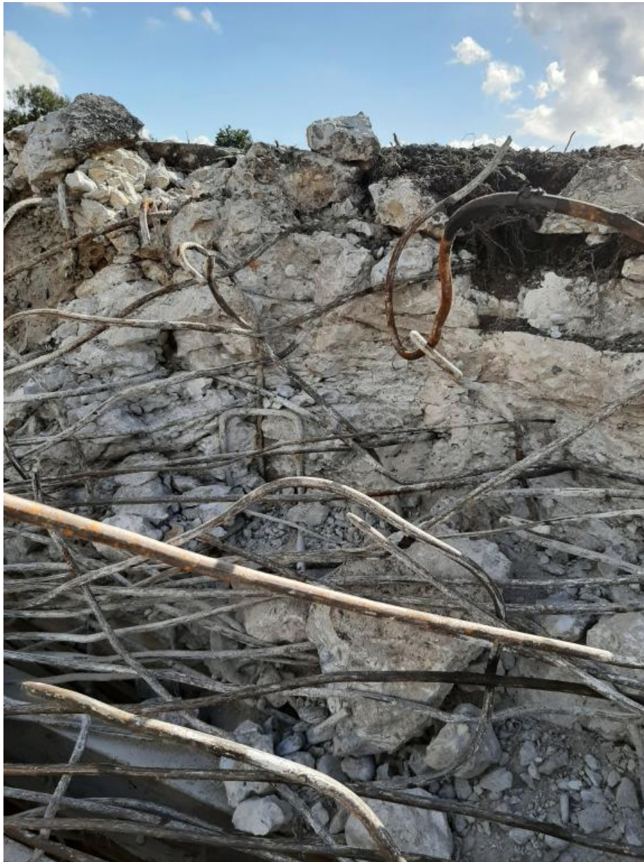
Vue de la déconstruction : matériaux de la dalle de couverture et des murs périphériques (25 septembre 2022)
