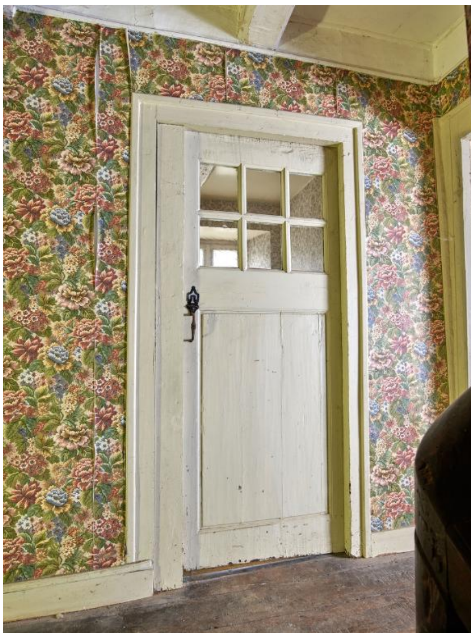
Logis 1831. Palier de l'étage. Porte à imposte d'une petite chambre
