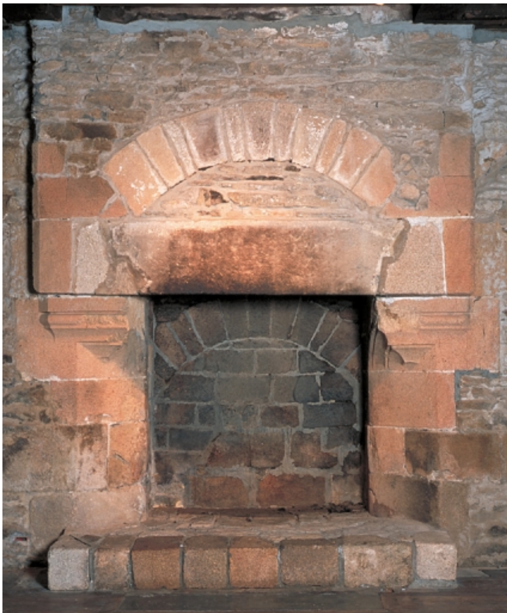
Rez-de-chaussée, cheminée sud
