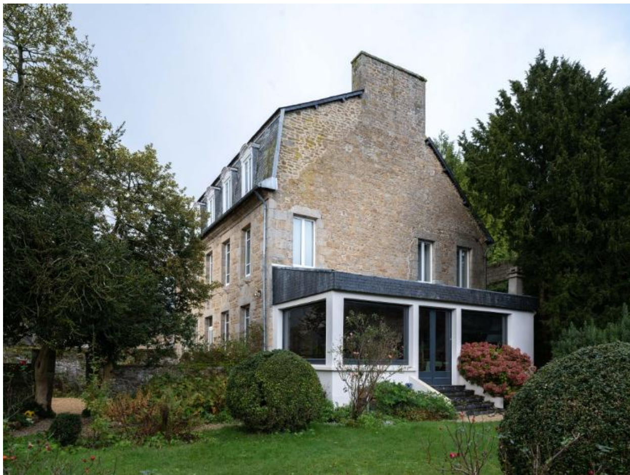
Pignon est. Vue générale sud-est. Surélévation du toit visible dans le changement de mise en oeuvre
