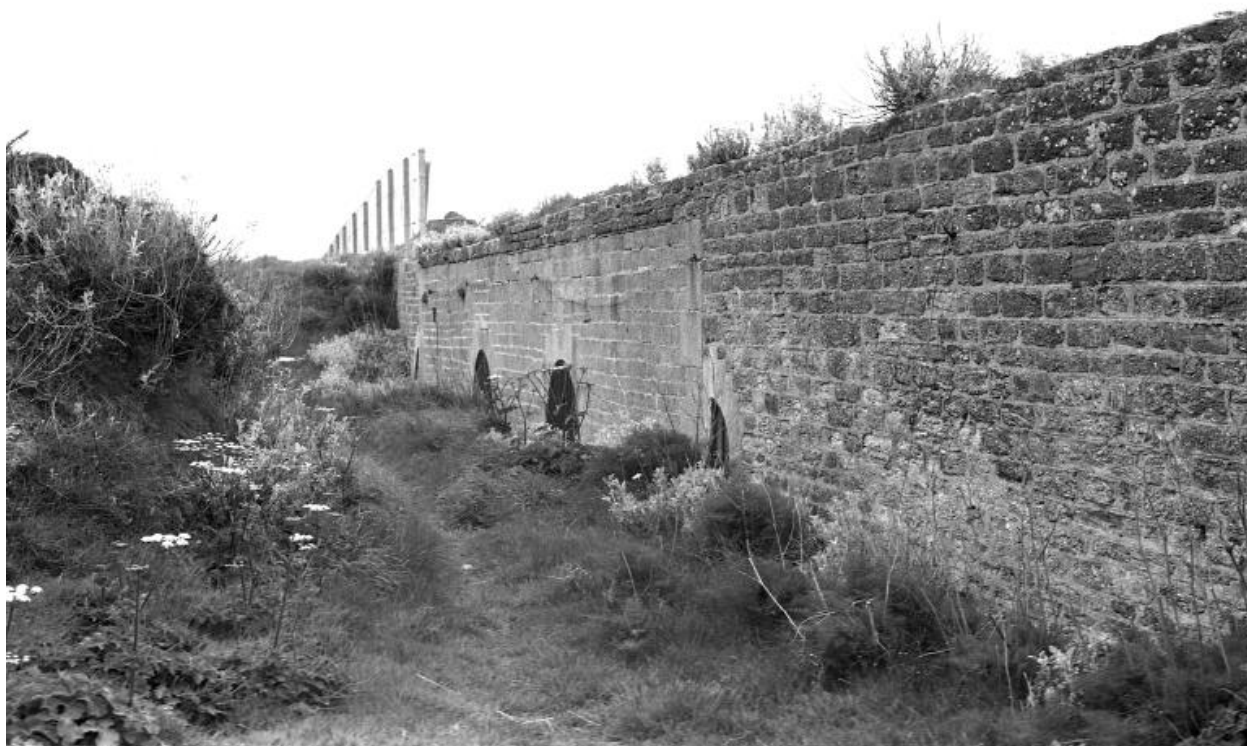
Réduit et fossé de gorge
