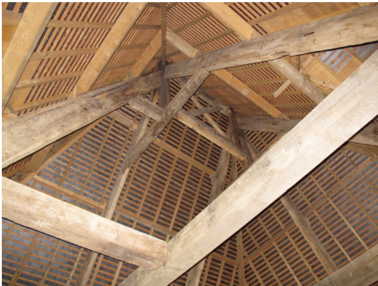
Charpente du pavillon du bâtiment sud-ouest
