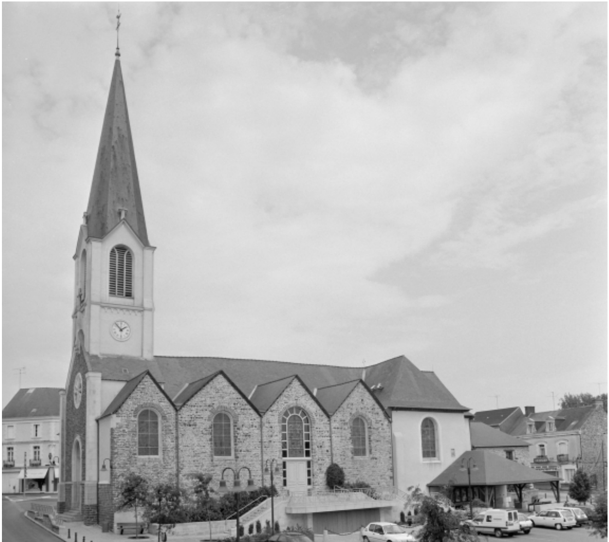
Elévation sud-ouest : vue générale
